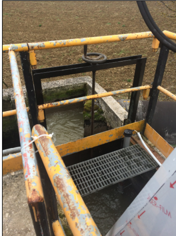
Figura 7: Paratoia in ingresso grigliatura da sostituire
