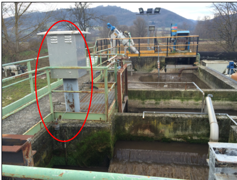
Figura 4: Misuratore di portata in ingresso da sostituire
